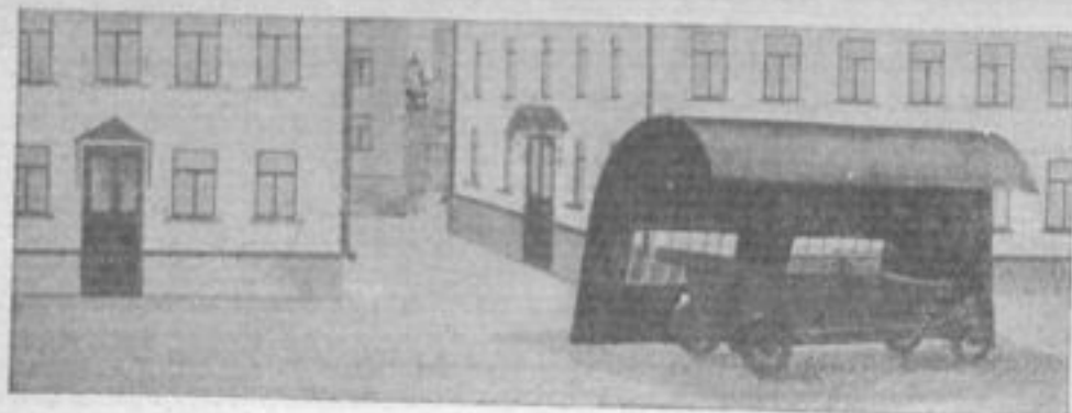
Рис. 2. Гараж в городе в процессе монтажа
